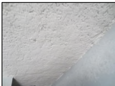
Photo N° 610 ECH-N°1 FLOCAGE -- HALL Plafonds BLANC COTONNEUX
